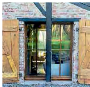
Historische Klappläden umrahmen das Badezimmerfenster in der umgebauten Scheune. Foto: Claus Völker
